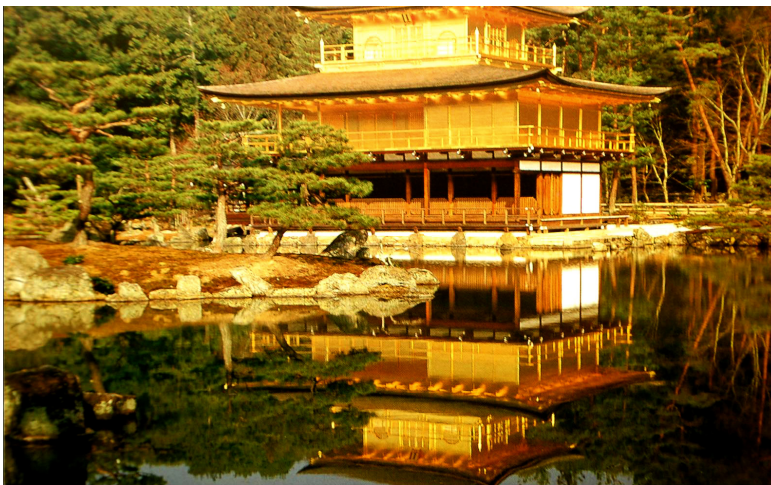
Afb. 3. Het Gouden Paviljoen ( Kinkakuji ) met tuinvijver te Kyoto, 1394. Door brand verwoest in 1950 en herbouwd in 1964.
